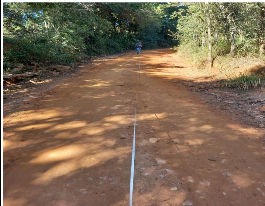
Descrição: Estrada Garcias
